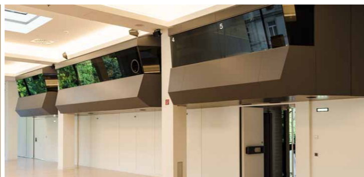
2. Obergeschoss Kongressaal 2 | Simultan-Dolmetscherkabinen
