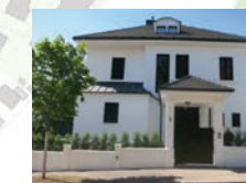
B Zeppelinstr. 1 Villa in reduzierter Reformarchitektur. Farb-wert und Helligkeit gebiets-fremd, Dachziegel, Fensterrahmen und Rol-ladenfarbe struktur-fremd verändert.
